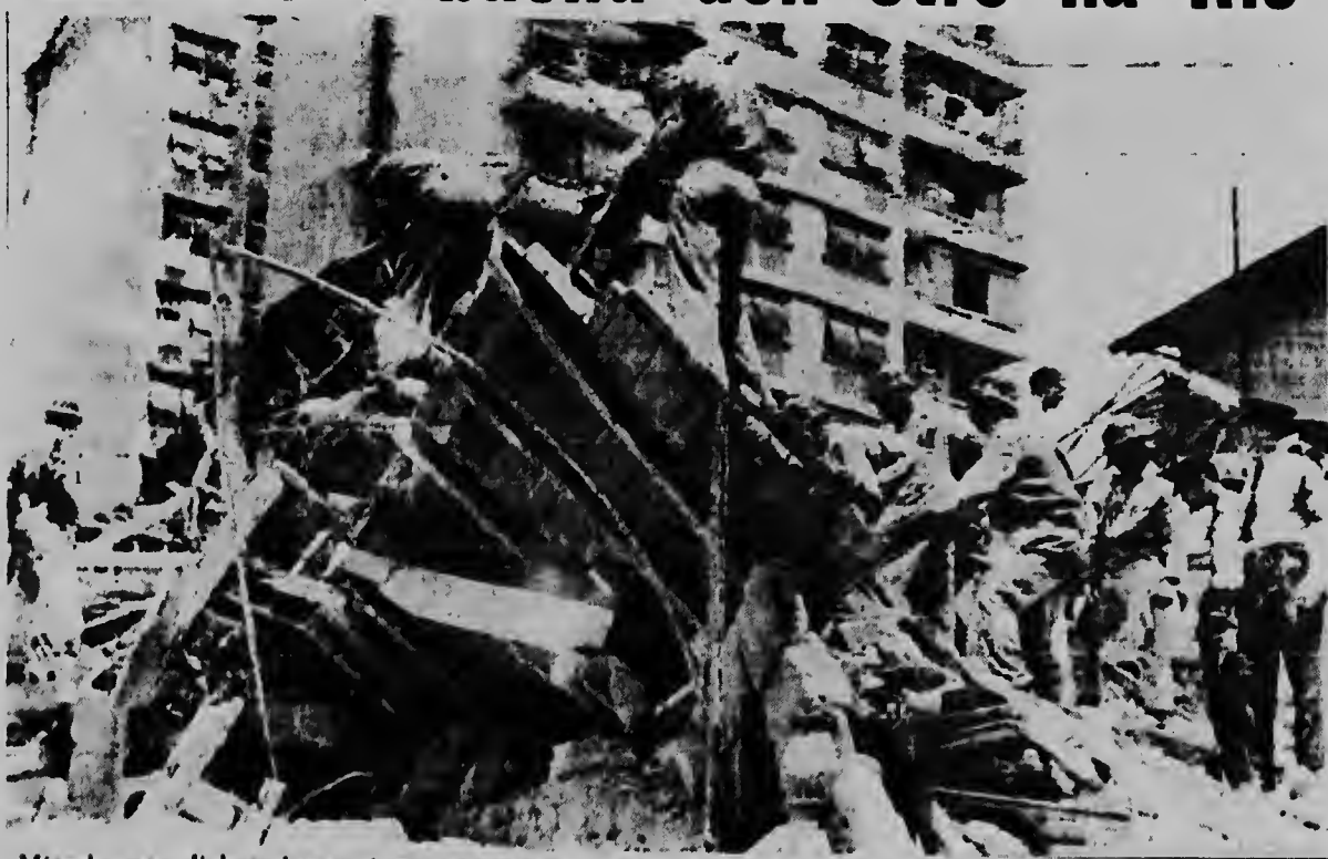
Miembronan di brandweer di Rio de Janeiro aki ta buscando entre e ruinan di un edificio di tres piso qu a basha den otro atrapandopor lo menos 14 persona. Nan a saca ocho te awor aki pero te ainda mester tin seis hende den e ruinan. E desaster a bini despues di e tercer tormenta di awaserru den tres luna qu a azota e ciudad, matando 1100 hende te awe. - UPI Radiophoto.-
